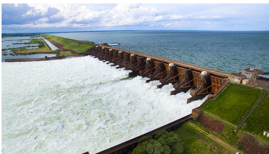
Figura 16. Central Hidroeléctrica de Yacyretã. Fuente: Entidad Binacional Yacyretã
