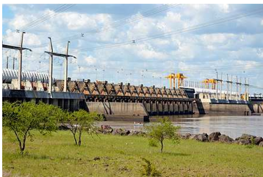
Figura 11. Represa de Salto Grande. Fuente: Complejo Hidroeléctrico Salto Grande http://www.saltogrande.org
