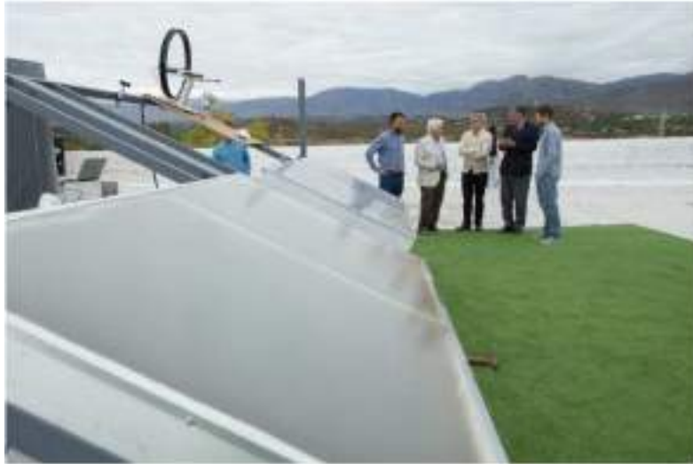
Figura 39. Terraza de la facultad de UNCuyo con colectores solares térmicos.
