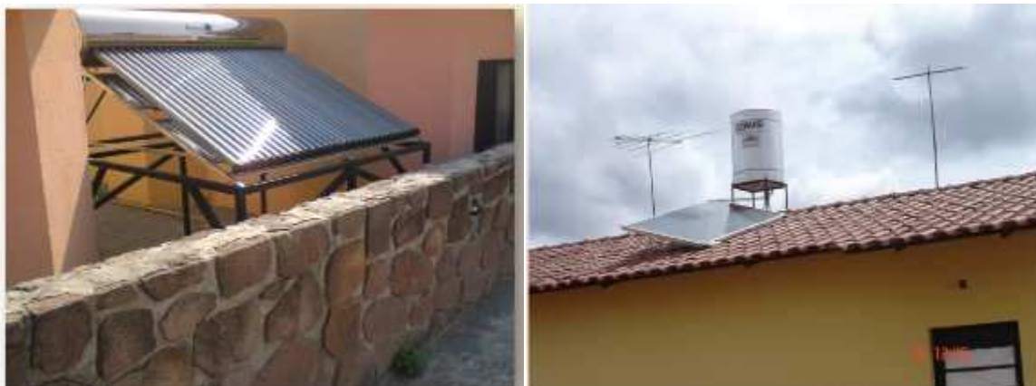
Figura 30. Arriba, buena instalación del colector solar. Abajo, mala localización de dos colectores solares, por deficiencias técnicas según normativa de México (el panel tiene sectores de sombra que impiden la captación de rayos solares directos) (36).
