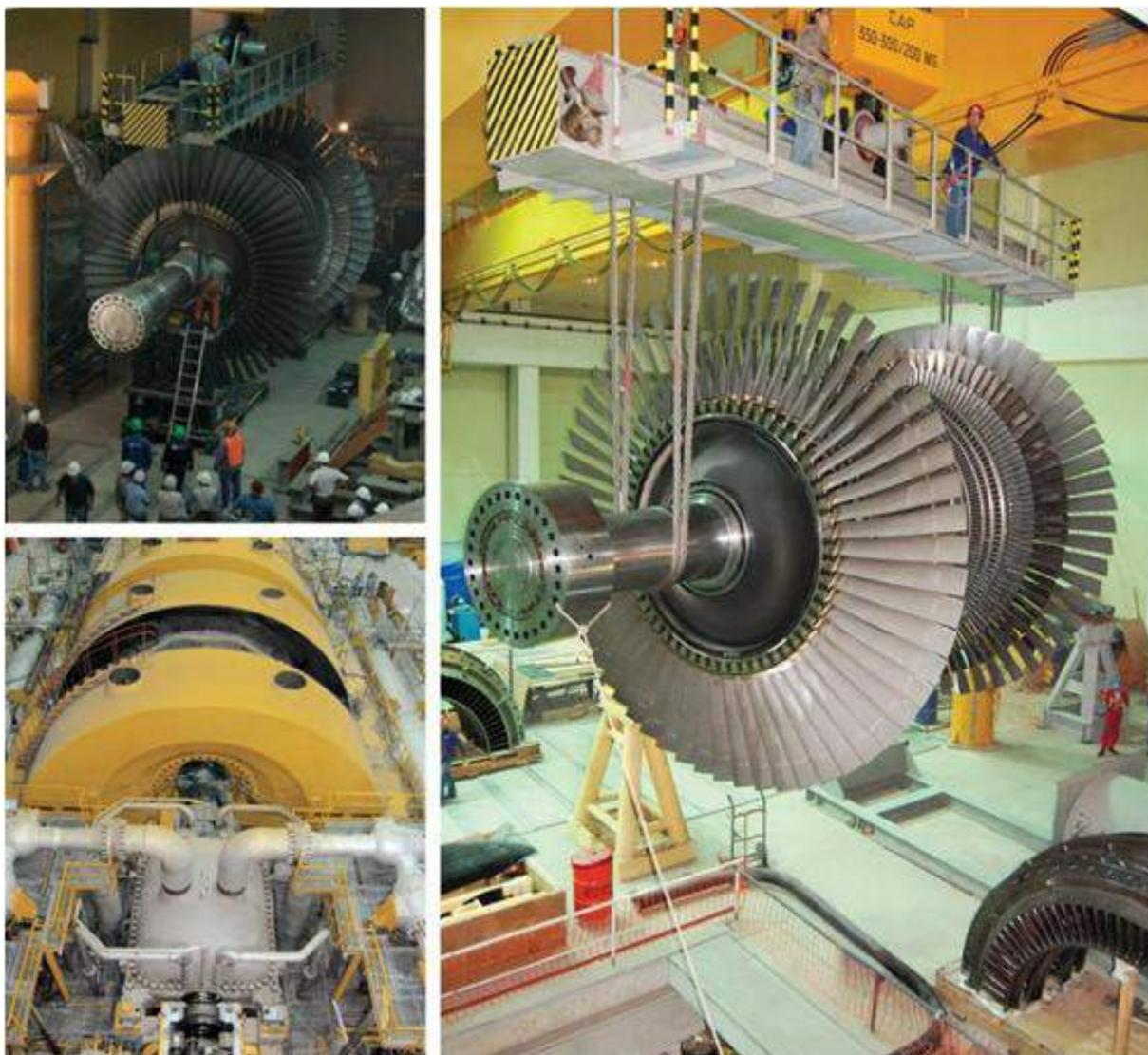
*Figura N°10: Montaje del turbogruppo de Atucha II*
