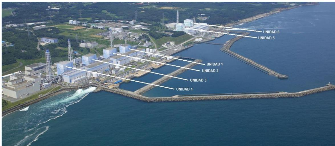
**Figura 7-2 Disposición de las seis unidades de la Central Nuclear de Fukushima en el sitio [35].**
