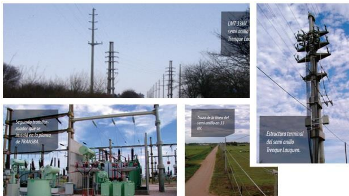
Figura 43. Obras realizadas en líneas y estaciones de transformación. Fuente COOPTL
