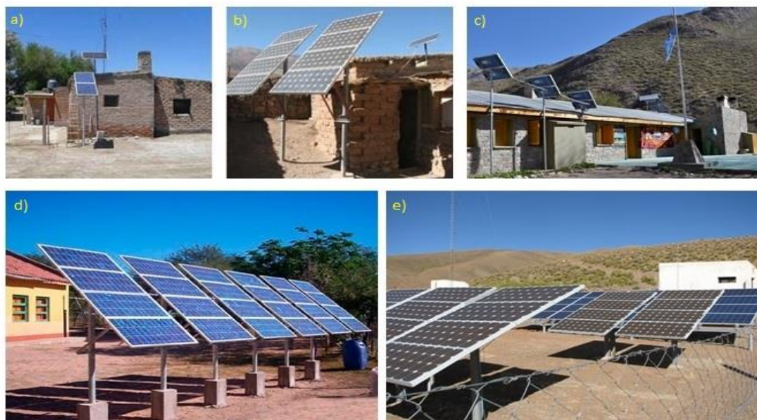
Figura 10. Instalaciones de generación distribuida en zonas aisladas. En las fotos a) y b) sistema instalado en hogares, figuras c) y d) suministro a escuelas. Imagen e) instalación en configuración de micro-red. Fuente: Subsecretaría de Energías Renovables y Eficiencia Energética, Ministerio de Hacienda.
