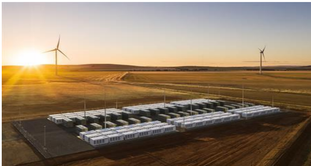
Figura 25. Banco de baterías provisto por Tesla, instalado junto al complejo eólico Hornsdale en el sur de Australia, desarrollado por la compañía francesa Neoen. Foto: Clément Viaud (Asset Manager, Neoen Australia). Arena Insights fórum. Noviembre 2018.
