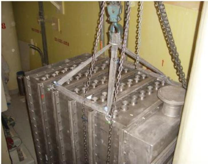
Figura A4-5 Dry Filter Method (DFM). La principal ventaja es su instalación modular y bajo costo
