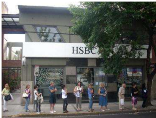
Figura 14. Vista exterior- frente del edificio
