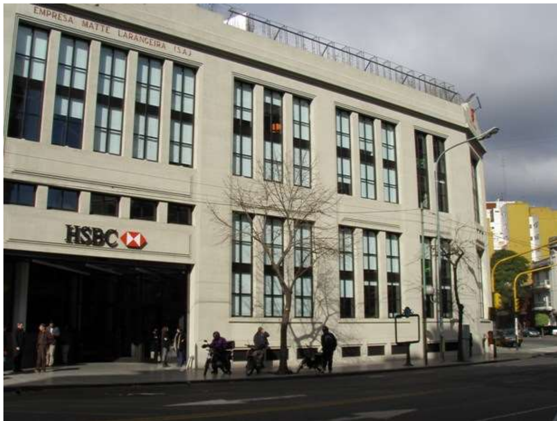
Figura 23. Exteriores del edificio
